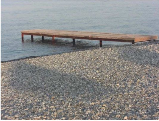
Fig. 11: Pier construction in the beginning of the summer in 2009 Abb. 11: Stegkonstruktion am Anfang des Sommers 2009
