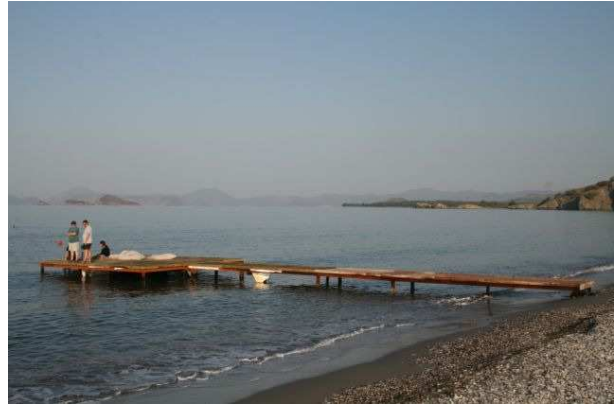
Fig. 12: Pier construction in August 2009 Abb. 12: Stegkonstruktion im August 2009
