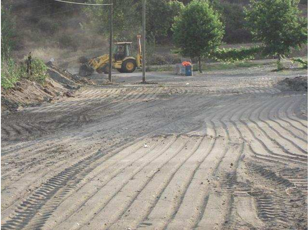
Fig. 16a: Excavation work at small beach, northern end of Yaniklar beach (Photo: C. Fellhofer) Abb. 16a: Bauarbeiten am Small Beach, dem nördlichen Ende von Yaniklar Strand
