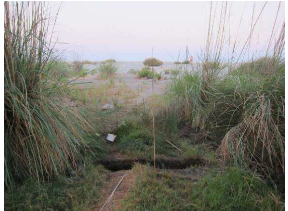
Abb. 16: Graben bei der vierten Ausfahrt. Fig. 16: Ditch at AP 4.
