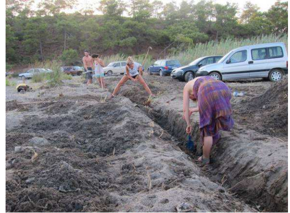
Abb. 14: Ausheben des Grabens bei der neuen Parkfläche. Fig. 14: Digging the ditch at the new parking area
