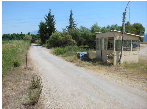
Abb. 2: Kontrollhäuschen vor dem Strand. Fig. 2: Control house on the beach
