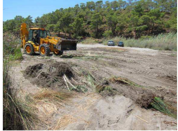
Abb. 8: Ein Bagger baut eine neue Parkfläche vor dem Strand. Fig. 8: An excavator bulldozing a new parking area.
