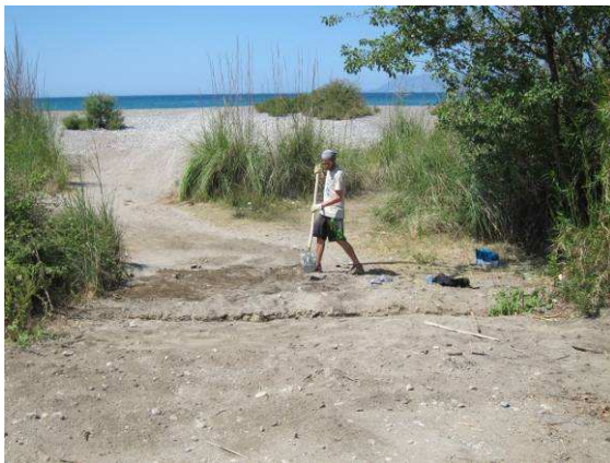
Abb. 15: Ausgraben der Barriere bei der dritten Zufahrt. Fig. 15: Digging the ditch at AP 3.
