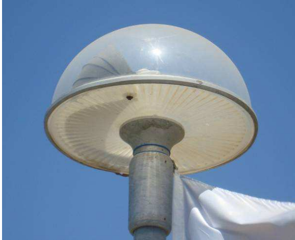
Fig. 3: Lantern on the beach of Calis with beach-facing part partially shielded (Photo: B. Böswart) Abb. 3: Laterne mit Abschirmung am Strand von Calis
