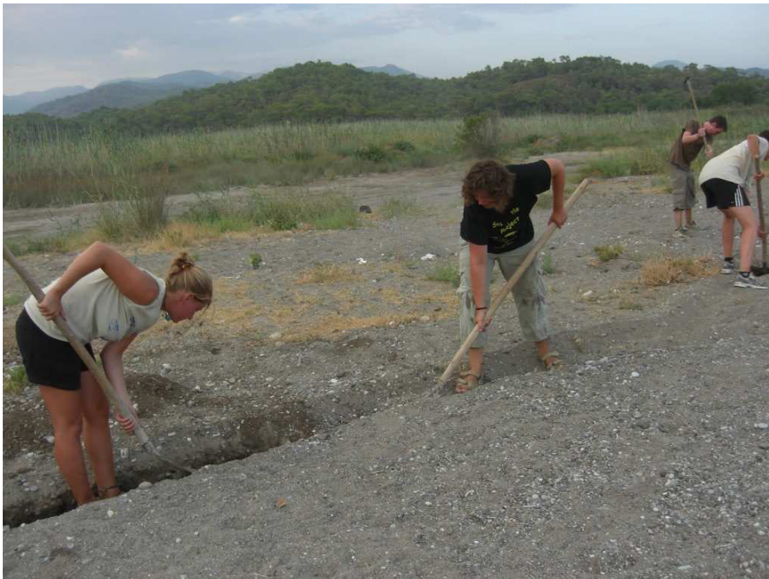
Fig. 3c: Digging ditches at the end of Akgöl beach (2012; Photo: C. Fellhofer) Abb.3c: Gräben werden am Ende des Strandes von Akgöl gegraben (2012)
