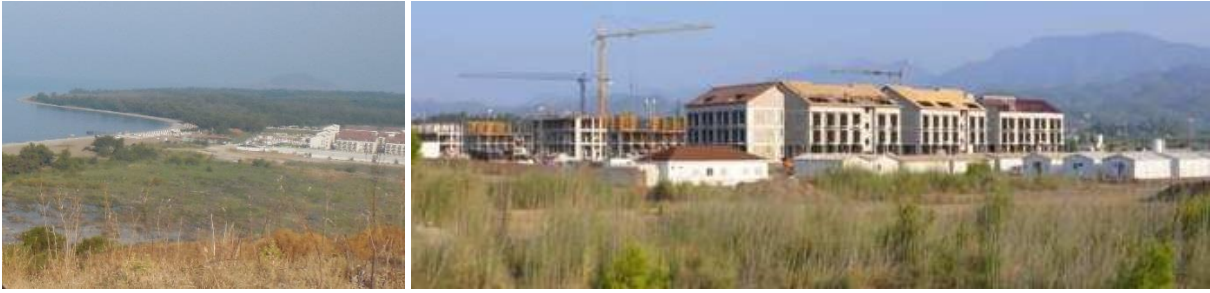
Fig. 7: Barut Sensatori Fethiye: left – 2015 in operation, right – 2014 still under construction Abb. 7: Barut Sensatori Fethiye: links – 2015 Anlage bereits in Betrieb, rechts – 2014 noch im Aufbau (Photo: 2014 M. Stachowitsch, 2015 A. Kluge)
